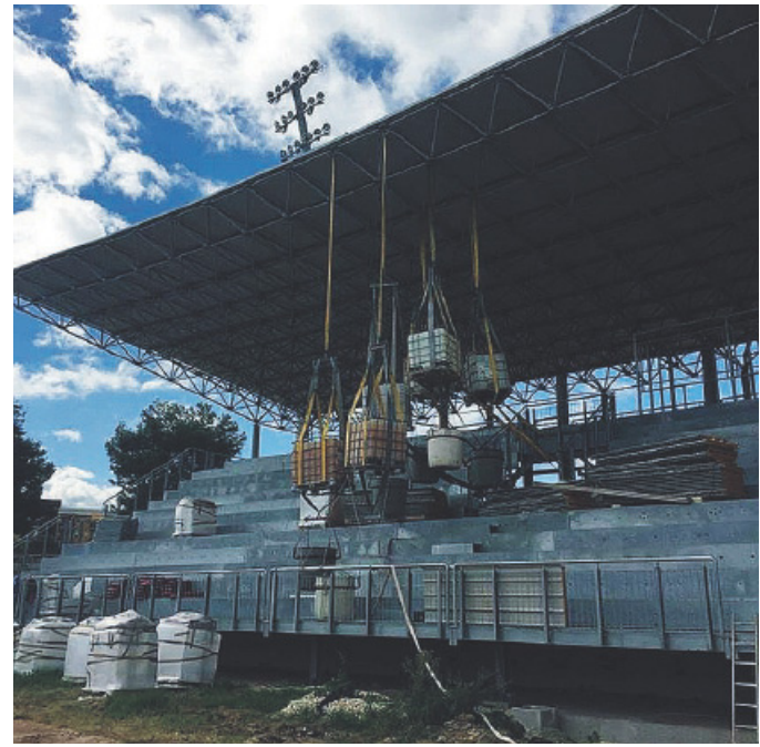
STADIO «PUTTILLI» Barletta, le prove di carico sulla nuova tribuna dell'impianto sportivo di via Vittorio Veneto
