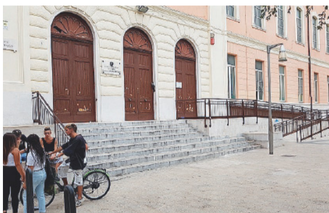
STUDIO E LAVORI La scuola Massimo D'Azeglio
