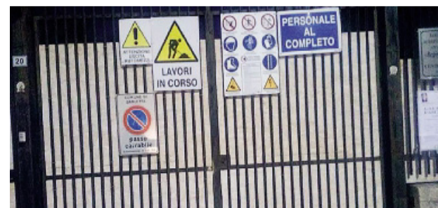
BARLETTA L'ingresso della Casa di riposo, chiuso per lavori
