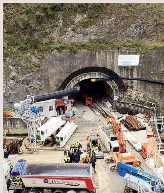
PAVONCELLI I lavori alla galleria bis (foto da Pdcaposele)
