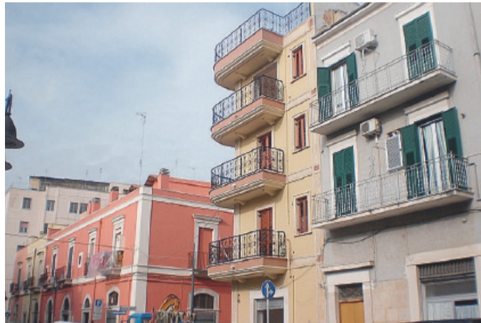
DOPO L'INTERVENTO L'edificio in via Roma
