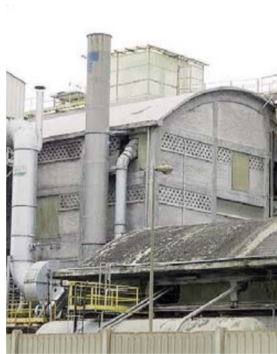
TIMAC Lo stabilimento in via Trani
