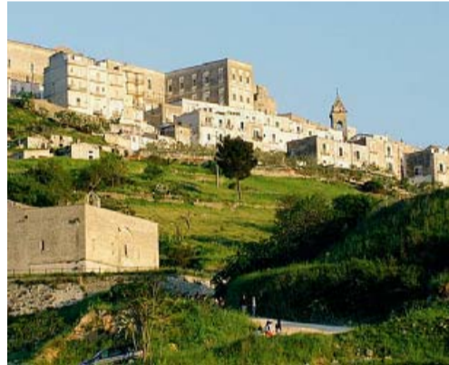
MINERVINO Riflettori puntati sulle strade provinciali, in particolare sui lavori di consolidamento stradale nel tratto compreso tra il km 21 ed il km 24 della Strada Provinciale Bat n°4
