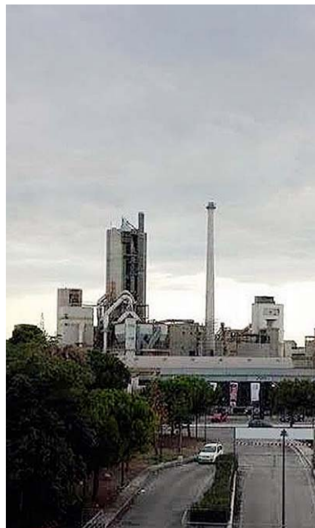
BARLETTA Al centro della foto, la cemenetria e la ciminiera costruita nel 1970 e dismessa nel 1993 in via di abbattimento
