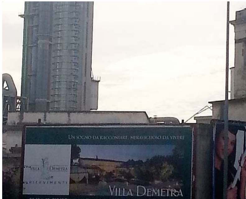
IN GABBIA L'impalcatura avvolge già la vecchia ciminiera della cementeria
