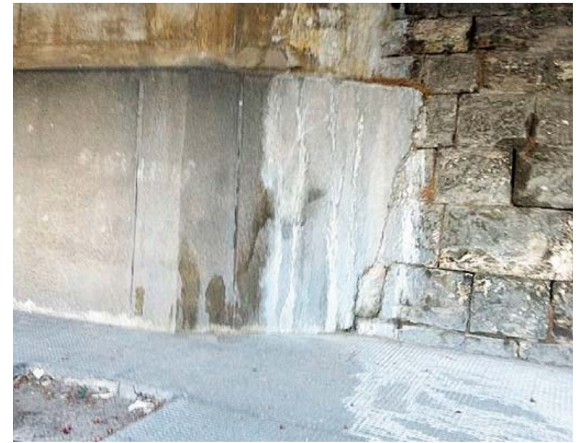
ECCOLE DI NUOVO Le tracce lasciate su costone e marciapiede in via della Misericordia
