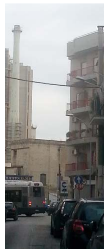
La ciminiera della cementeria
